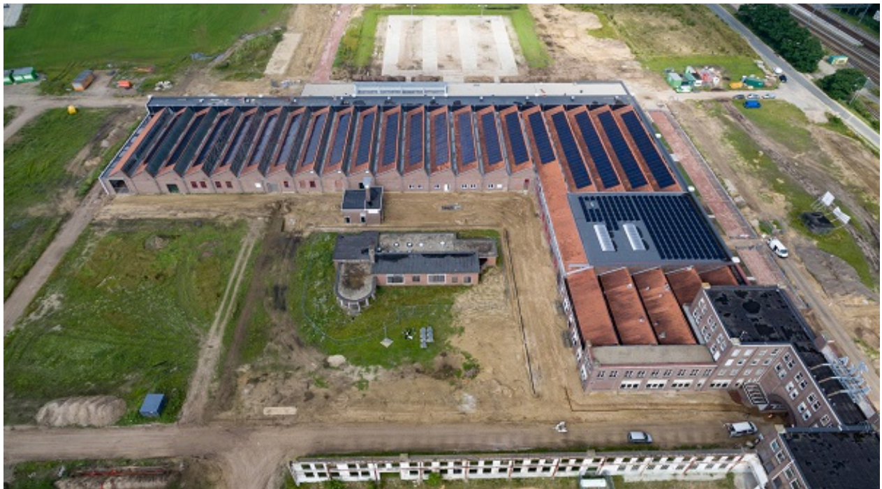
Op het ENKA-terrein in Ede is bij de restauratie van de Westhal extra aandacht besteed aan de verduurzaming van het gebouw en met resultaat: de Westhal is een van de grootste energieleverende rijksmonumenten van Nederland geworden. (Foto: BOEi, Jan van Dalen).
